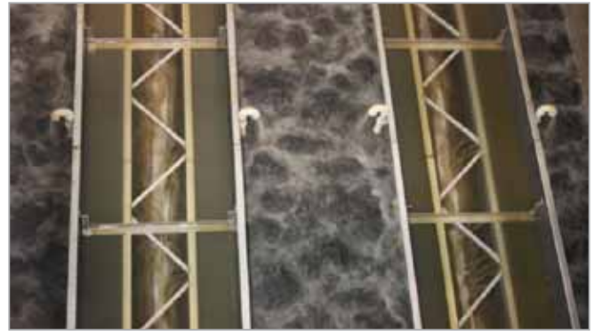
Bir içme suyu uygulamasındaki MULTIWASH prosesi
