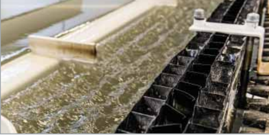
Geliştirilmiş Durultma İçin Tüp Çöktürücüler
